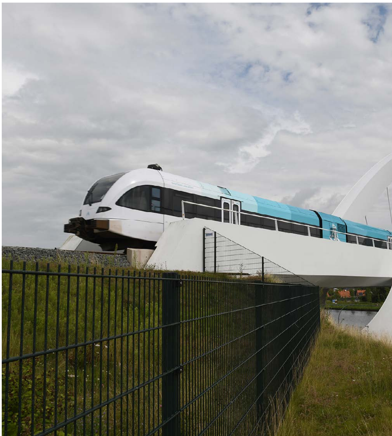
Waterstofrein Zuidhorn spoorbrug
